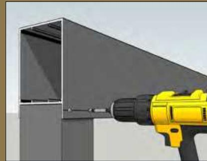
**5.** Bereiten Sie das Wandprofil, wie auf den Seiten 20 u. 21 beschrieben, vor. Anstatt das Wandprofil an der Hauswand zu befestigen, befestigen Sie es mit den selbstsneidenden Schrauben (Schraube E). Übertragen Sie die Löcher im Wandprofil auf das Statikprofil und bohren Sie diese mit einem 4,5-mm Metallbohrer vor. Schrauben Sie dann das Wandprofil an und versiegeln Sie die Naht zwischen Wandprofil und Statikprofil mit einem säurefreien Silikondichtmittel.
